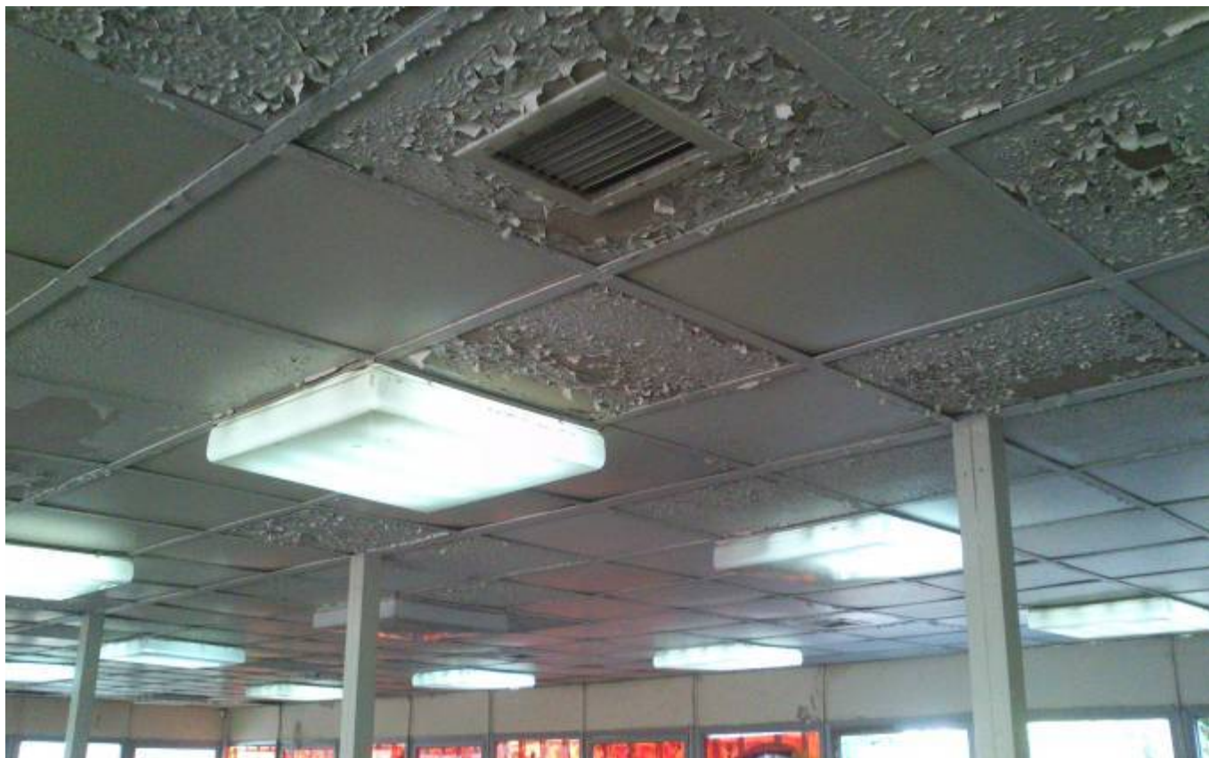
Εικόνα 5: Οροφή – Τμήμα Φαρμακευτικής
