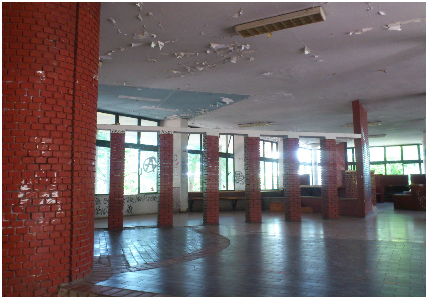
Εικόνα 11: Εντευκτήριο Πολυτεχνικής – «Τρίγωνο» Αρχιτεκτόνων
