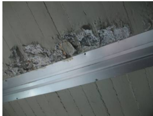
Εικ. 3 – Τοπικές υγρασίες σε φωτιστικά οροφής και αρμούς
