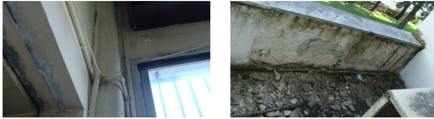
Εικ. 2 - Τοπικές υγρασίες εντός του εργαστηρίου και μη μονωμένο δώμα δίπλα από αυτό
