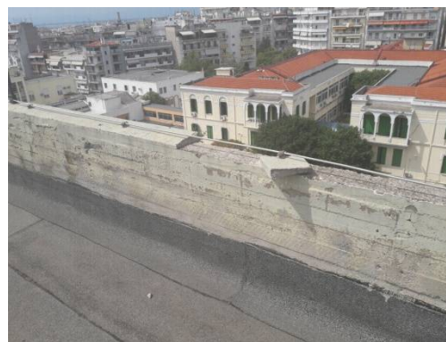
Εικ.3 – Ανεπαρκής σφράγιση αρμών και αποκόλληση στέψης στηθαίων δώματος
