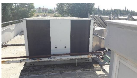
Εικ. 3 – Σύστημα ψύξης-θέρμανσης (αριστερά), απόληξη φεγγίτη (δεξιά)
