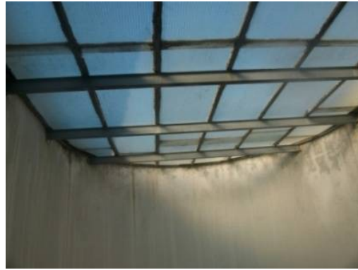
Εικ. 2 - Στέγαστρο με πολυκαρβονικά φύλλα σε όλα τα κλιμακοστάσια των κτιρίων
