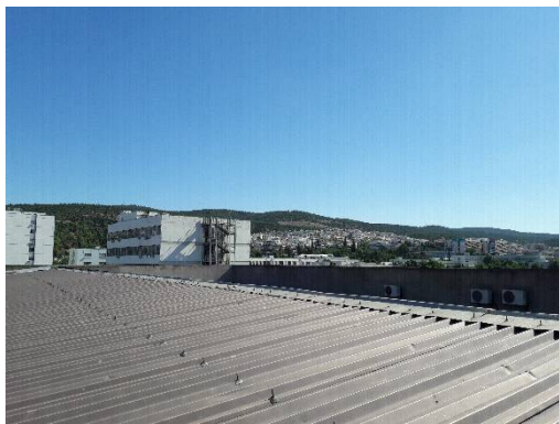
Εικ.2 – Άποψη μεταλλικού στεγάστρου βορειοανατολικού τμήματος
