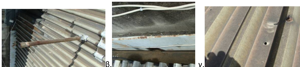
Εικ 3 - Στέγαστρα κτιρίων MOMA
