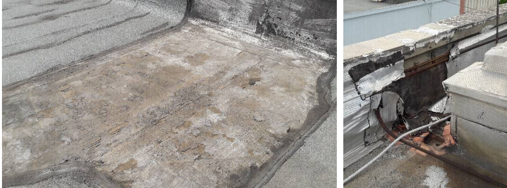
Εικ.2 – Παλαιές και αποκολλημένες ασφαλτικές μεμβράνες
