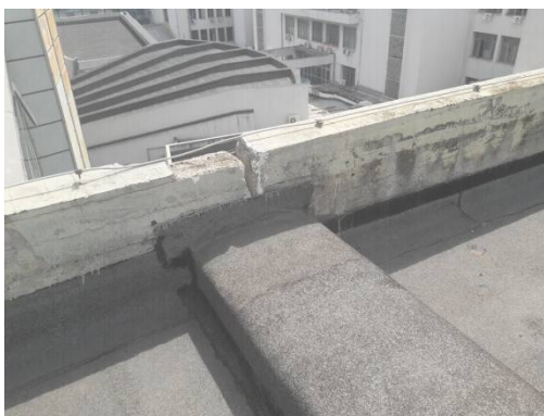
Εικ.3 – Ανεπαρκής σφράγιση αρμών και αποκόλληση στέψης στηθαίων δώματος
