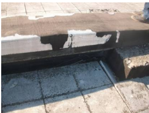
Εικ. 5 – Άποψη αρμού κτιρίου Ε
