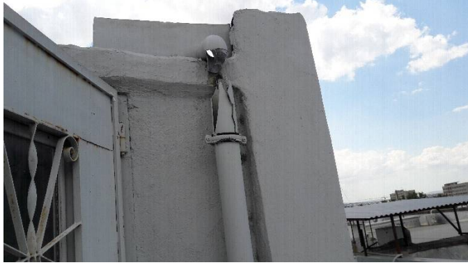
Εικ.5 – Ρηγματωμένη και φραγμένη υδροροή
