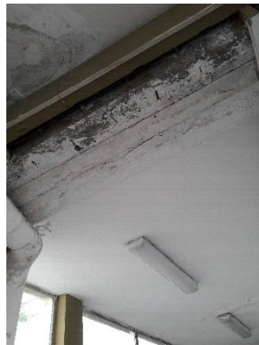
Εικ.6 - Υγρασίες σε εσωτερικούς χώρους κάτωθι του δώματος
