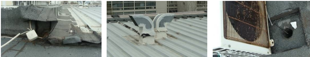
Εικ.5 α. Αρμός στεγάστρου – δώματος β. Απολήξεις Η/Μ εγκαταστάσεων στο μεταλλικό σκέπαστρο δώματος γ. Φρεάτιο υδρορροής στο σθηαίο πίσω από τους φεγγίτες στη νότια πλευρά
