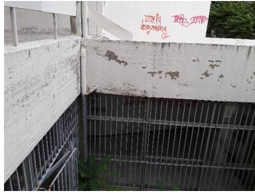
Εικ. 5 - (α) Σαθρά επιχρίσματα στα στηθαία του δώματος (β) κακή συναρμογή σε υδρορροές
