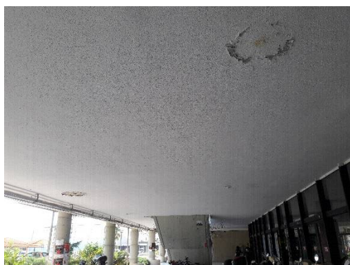
Εικ.1 – Υγρασίες στην οροφή
