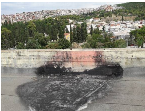
Εικ.2 – Καμένα ασφαλτόπανα σε δύο σημεία του δώματος
