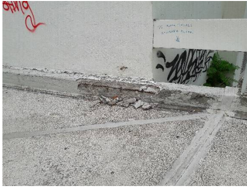
Εικ. 5 - (α) Σαθρά επιχρίσματα στα στηθαία του δώματος (β) κακή συναρμογή σε υδρορροές
