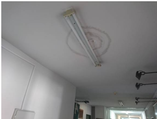
Εικ. 3 – Τοπικές υγρασίες σε φωτιστικά οροφής και αρμούς
