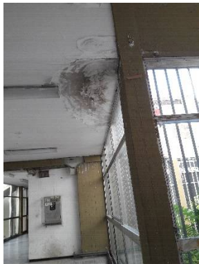
Εικ.6 - Υγρασίες σε εσωτερικούς χώρους κάτωθι του δώματος
