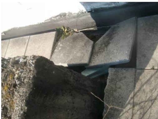
Εικ. 4 – Αναμονές υποστυλωμάτων στο δώμα
