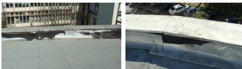
Εικ.5 - Δώματα ζώνης 5α, 5β και αμφιθεάτρου και θέσεις αστοχιών
