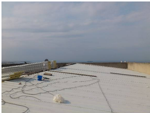
Εικ.3 – Άποψη μεταλλικού στεγάστρου νοτιοδυτικού τμήματος
