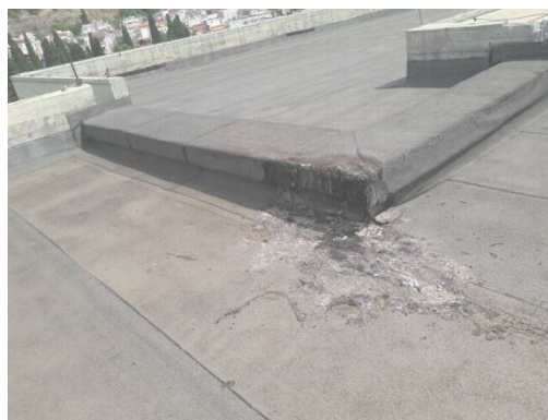
Εικ.2 – Καμένα ασφαλτόπανα σε δύο σημεία του δώματος
