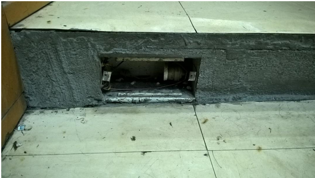
Εικόνα 5 – Φωτιστικά εγκατεστημένα στα σκαλοπάτια των αμφιθεάτρων
