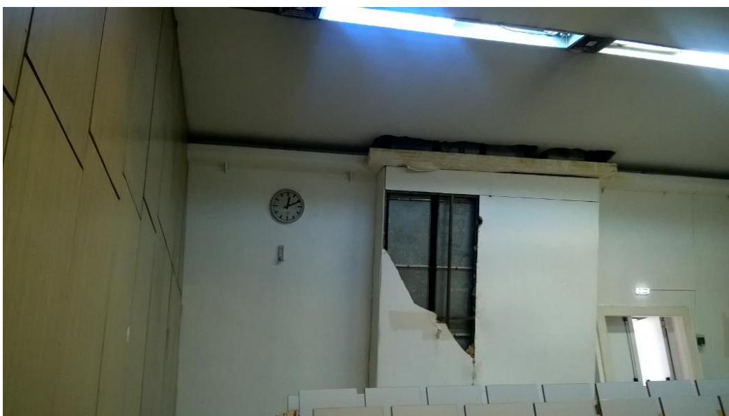
Εικόνα 3 – Αποξηλωμένο τοιχοπέτασμα μέσα σε αμφιθέατρο
