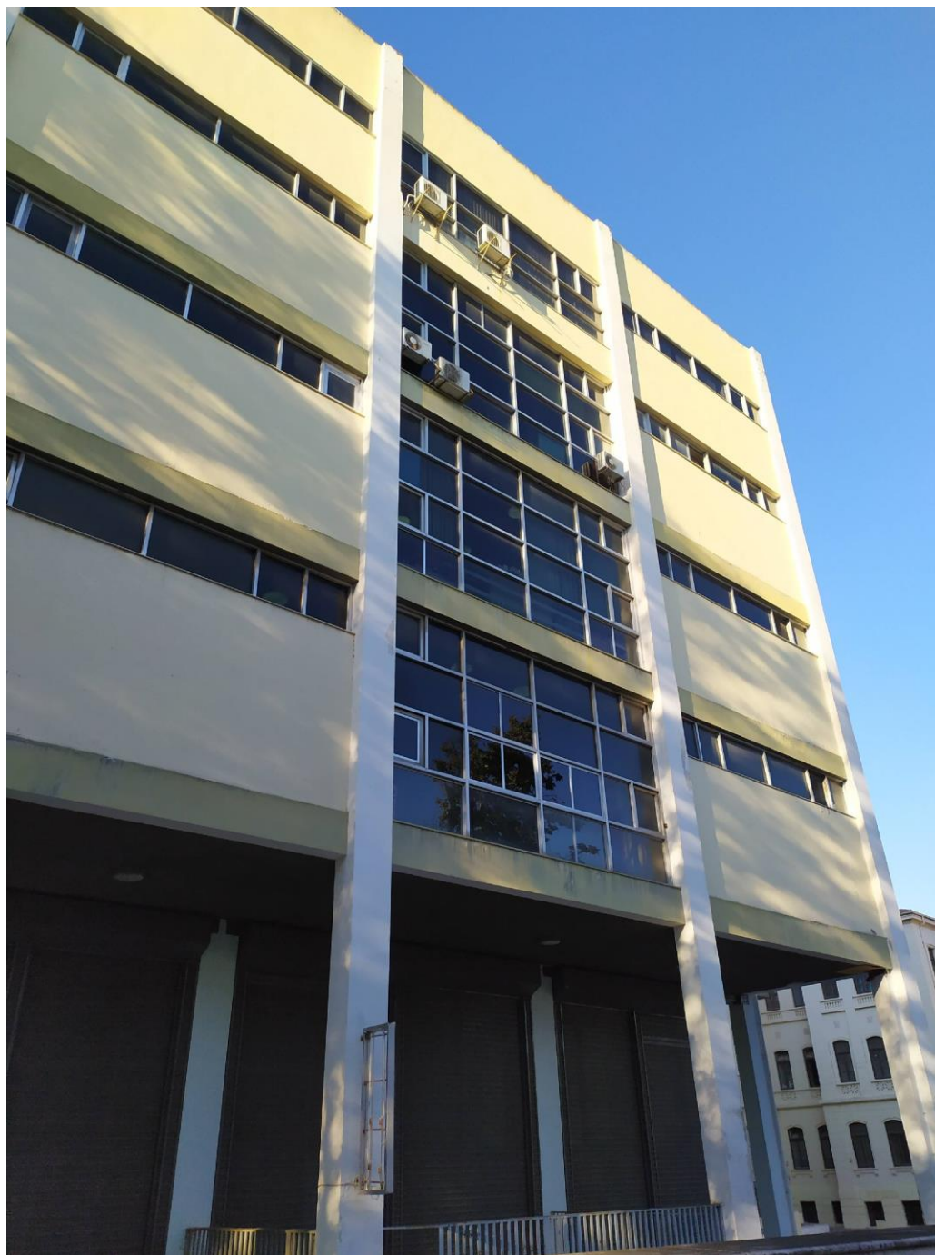
Εικόνα 4: Βορειοανατολική όψη κτιρίου
