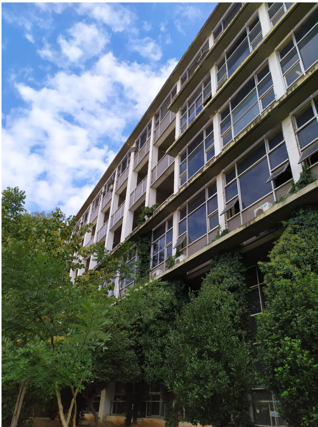
Εικόνα 5: Βορειοδυτική όψη κτιρίου
