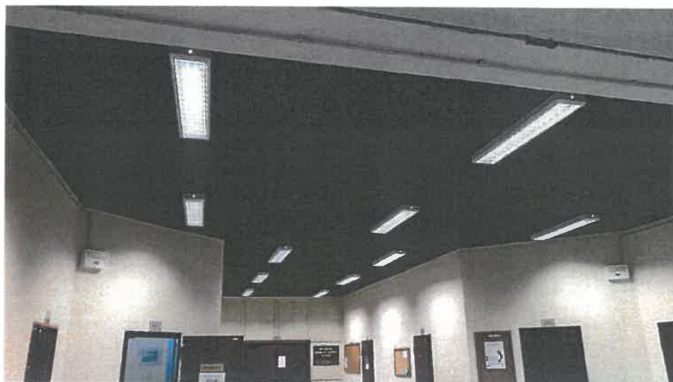
Εικόνα 7- Φωτιστικά σώματα φθορίου νέου τύπου με οθόνη από περσίδες αλουμινίου διπλής παραβολικότητας
