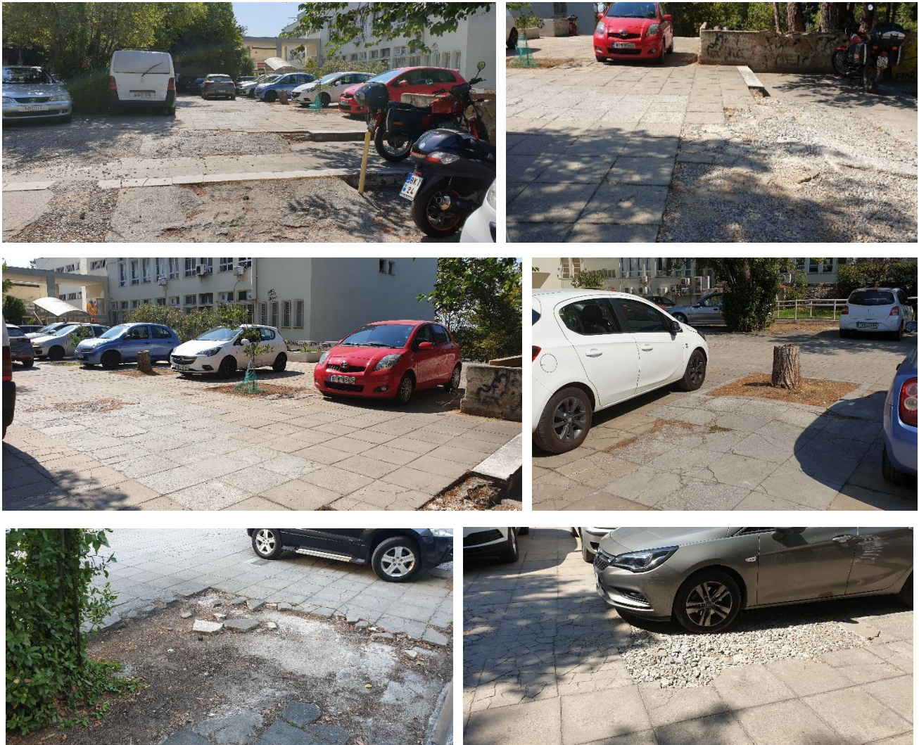
Εικόνα 3 - Υφιστάμενη κατάσταση αύλειου χώρου του κτιρίου Ιατρικής
