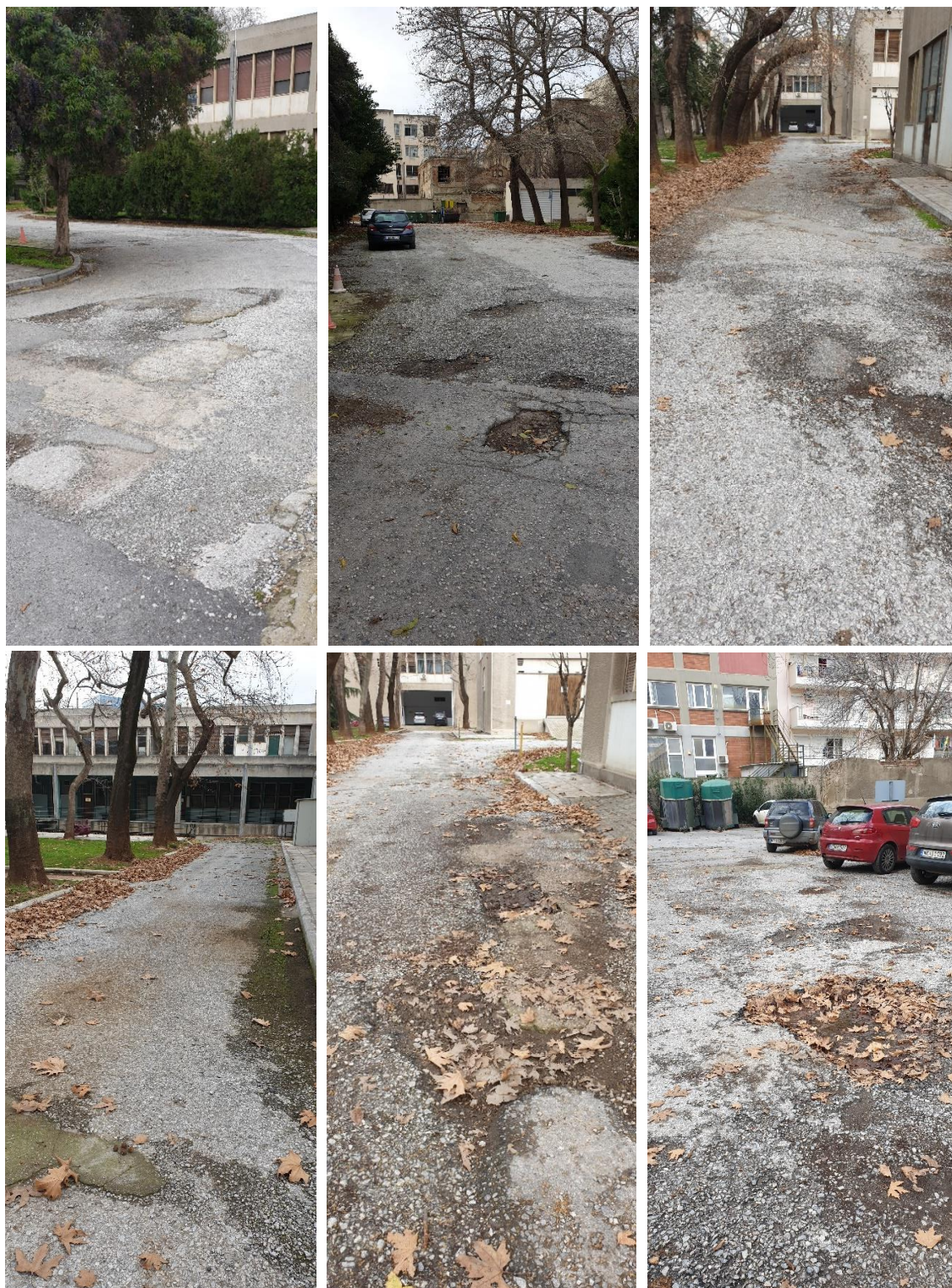
Εικόνα 2 - Υφιστάμενη κατάσταση οδικού δικτύου στις εγκαταστάσεις των Κλινικών Κτηνιατρικής
