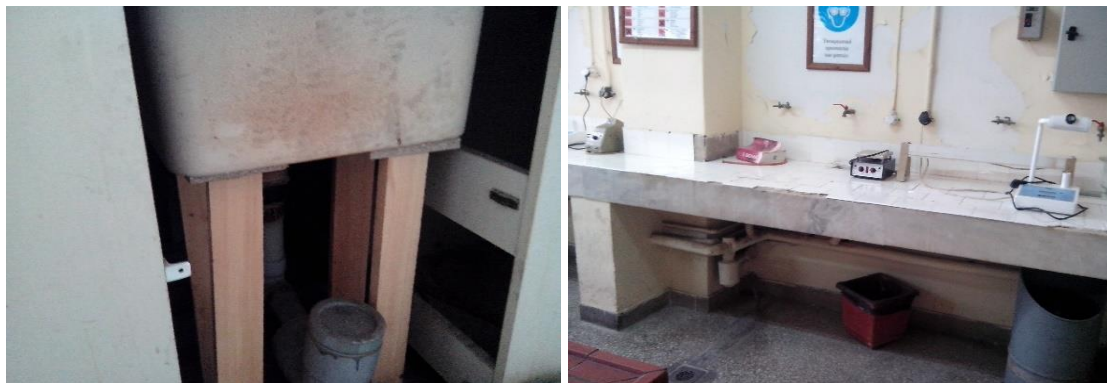
Εικόνα 11 - Στήριξη νιπτήρα εργαστηριακού πάγκου με ξύλα (αριστερά) - Εργαστηριακός πάγκος μαρμάρινος (δεξιά)
