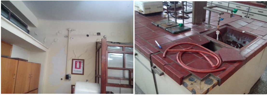
Εικόνα 9 - Κατεστραμμένα κεραμικά πλακίδια στην επιφάνεια των εργαστηριακών πάγκων
