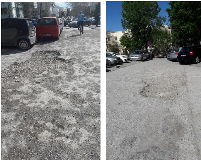
Εικόνα 3 - Υφιστάμενη κατάσταση οδικού δικτύου έμπροσθεν της ΣΘΕ
