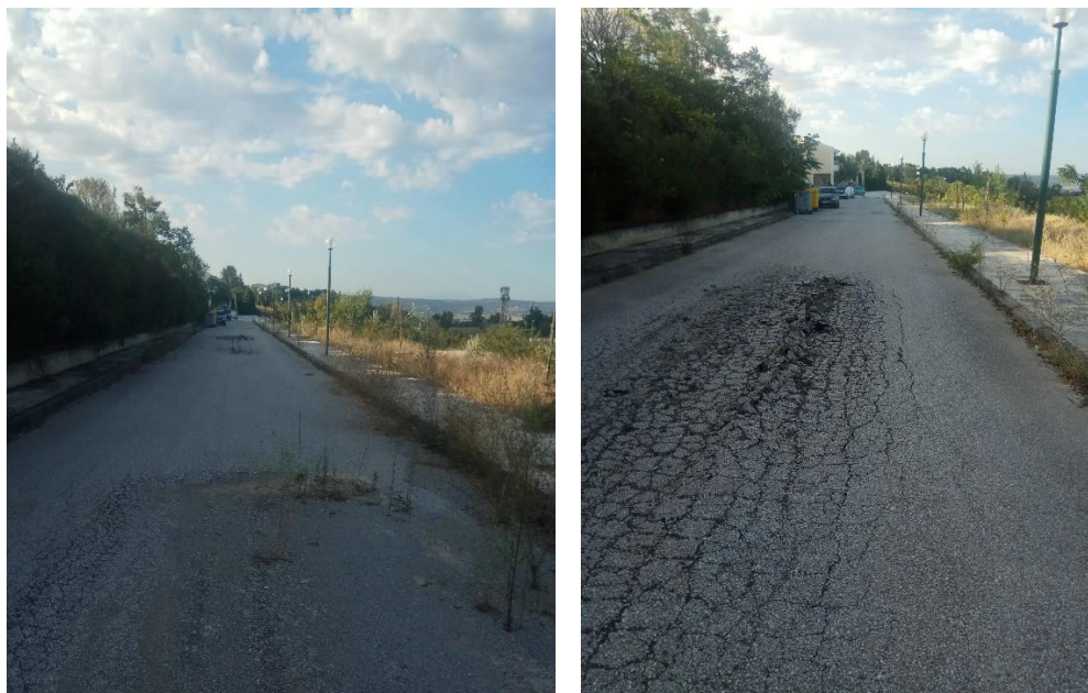
Εικόνα 2 - Υφιστάμενη κατάσταση τμήματος του περιφερειακού δρόμου στις εγκαταστάσεις της ΣΕΦΑΑ
