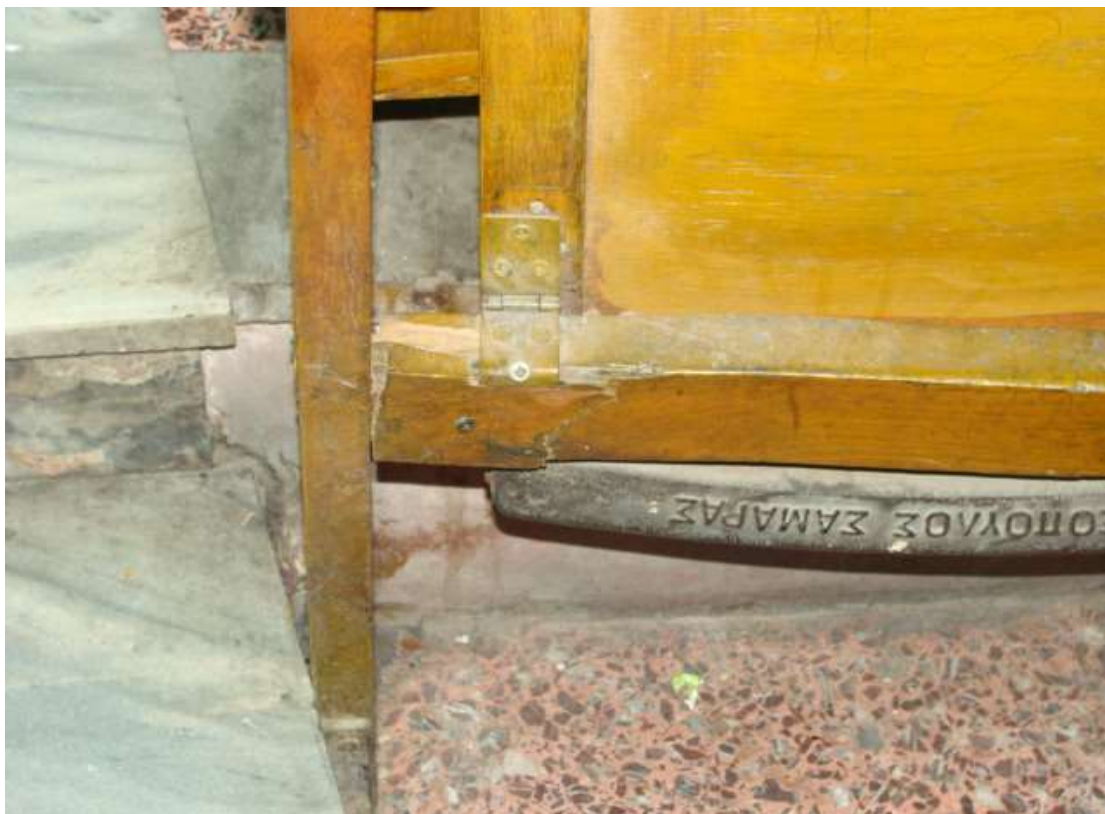
Φωτ. 6 Καταστραμμένη δοκός στήριξης του ανακλινόμενου καθίσματος
