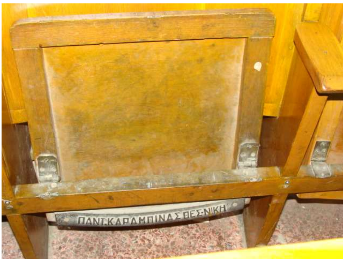
Φωτ. 7 Κατεστραμμένοι μηχανισμοί ανάκλησης – μεντεσέδες καθισμάτων
