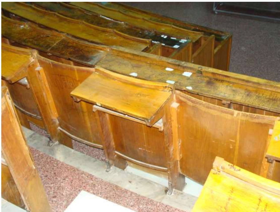
Φωτ. 8 Κατεστραμμένα έδρανα
