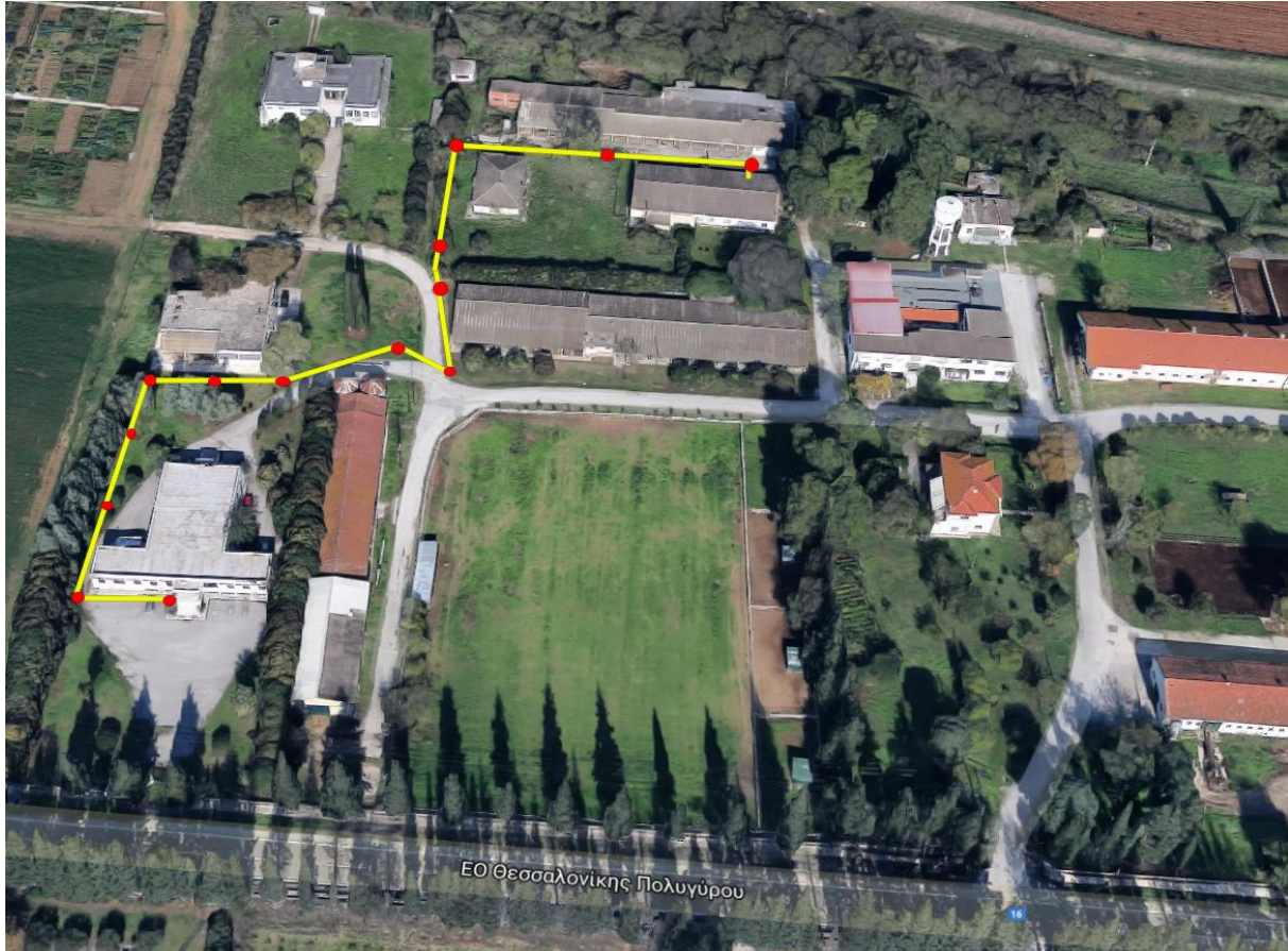
Σχήμα 2: Υφιστάμενη υποδομή για εγκατάσταση νέας ίνας μεταξύ κτιρίων του Αγροκτήματος
