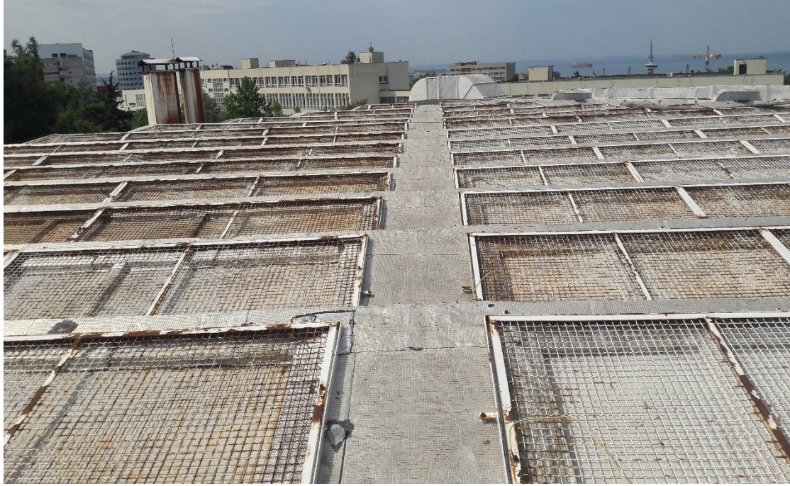
Εικόνα 2: Άποψη επιφάνειας δώματος υπό επέμβαση
