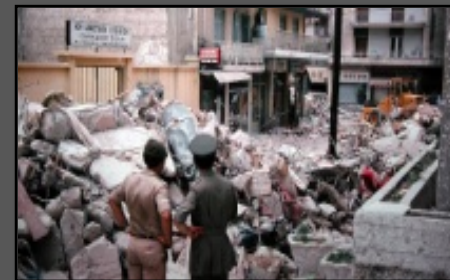
Από την κατάρρευση της πολυκατοικίας της οδού Ιπποδρομίου
